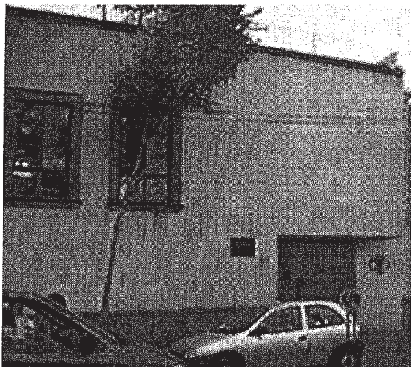
ADM plantel actual, Prolongación Xicoténcatl 24 Churubusco Coyoacán, fachada original.
