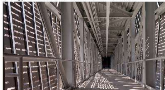
Imagen 3.1.29. Estructura de acero
