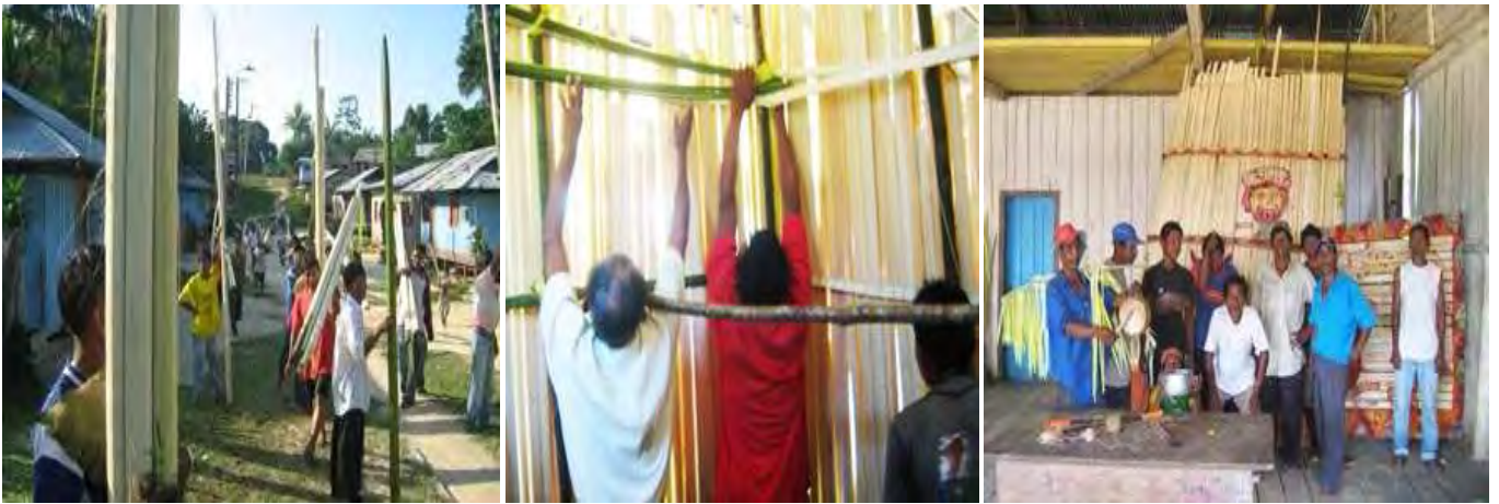
Foto 95. Construcción y pintura del corral de las Worekü 2008 Hugo Ramos
