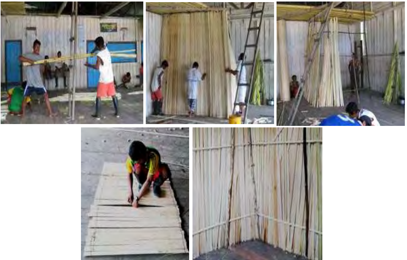
Foto 35. Proceso de construcción del corral, 2008, Hugo Ramos.
